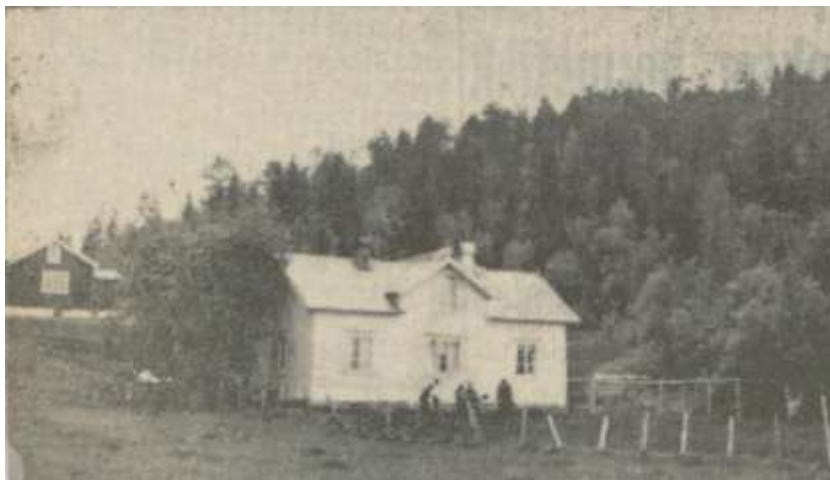
Feriehuset i Sandvika. Bilde kopiert fra Namdal Arbeiderblad (1956) 14. april
